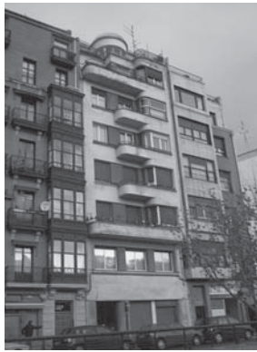
Edificio de viviendas en la calle Ripa N° 6, Bilbao, 1930-1932 (JIC)
