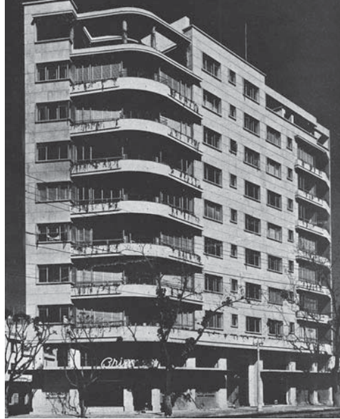
Juan de Madariaga. Edificio en la esquina de Av. Insurgentes y la glorieta de Chilpancingo, Ciudad de México, 1948 (RAM-1948)
