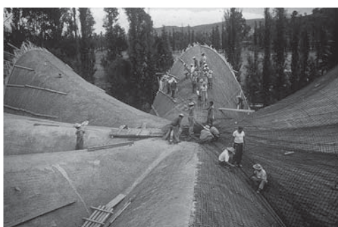
Proceso constructivo del restaurante Los Manantiales, Xochimilco, Ciudad de México, 1958. Foto Juan Guzmán (AFMT)
