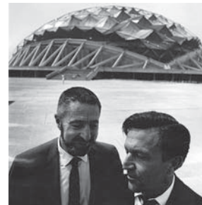
Félix Candela y Antonio Peyrí en visita de obra al Palacio de los Deportes, Ciudad de México, 1968
