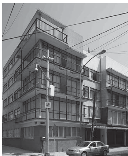
Jaime Ramonell. Edificio en la colonia Nápoles, Ciudad de México, c. 1963 (AMG)
