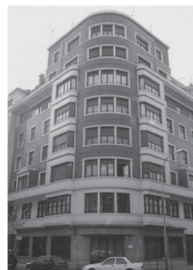
Edificio de viviendas en la calle Henao N° 5, Bilbao, 1933-1934 (ISG)
