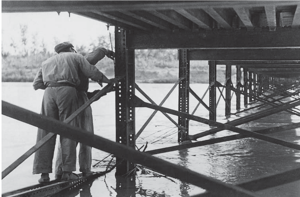
Foto Gutmann. Construcción de un puente sobre el río Ebro, diseñado por Ovidio Botella, agosto de 1938 (ABC)
