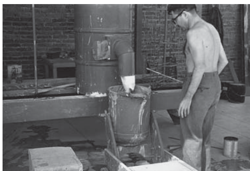
Candela experimentando con concreto aligerado. San Bartolo Naucalpan, Estado de México, 1949 (FDCA-PU)
