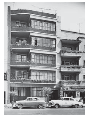
Esteban Marco y Fernando Rodríguez Miaja (constructor). Edificio en Río Nazas 77, Colonia Cuauhtémoc, Ciudad de México, 1949 (AFRM)
