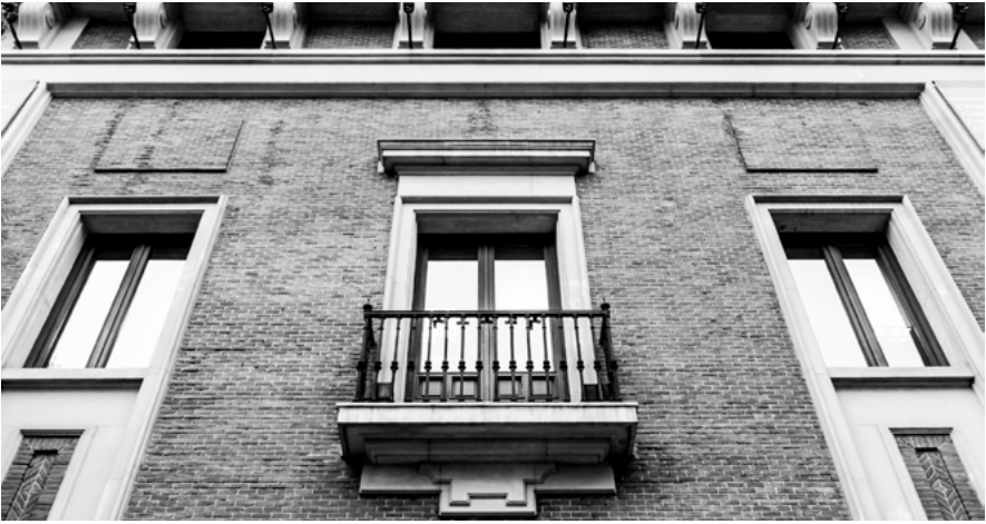
Fig. 1. Edificio para Valentín Ruiz Senén. Detalle de fachada. Luis Lacasa y Manuel Sánchez Arcas, Gustavo Fernández Balbuena, proyecto inicial, Madrid, 1925-1932. Foto: Verónica Trabucco y Sebastián D'Alessandro, 2018.
