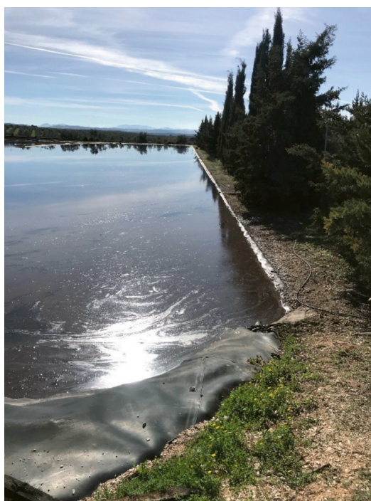
Figura 7.3.4.5: En esta imagen se aprecia el nivel de llenado de la tercera balsa y el rebose de la misma
