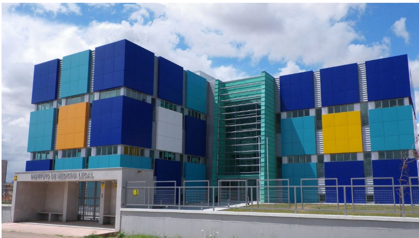
Ilustración 34. Señalización externa del IMLCF de Badajoz
